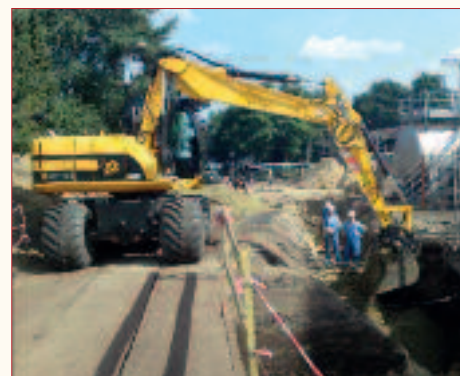
Nauwkeurig werken in een beperkte ruimte.
