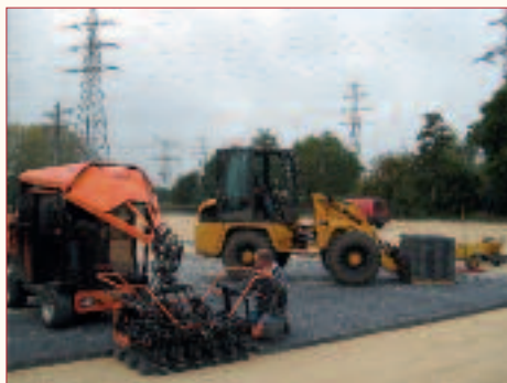
Machinaal profileren en aanbrengen van verhardingen.
